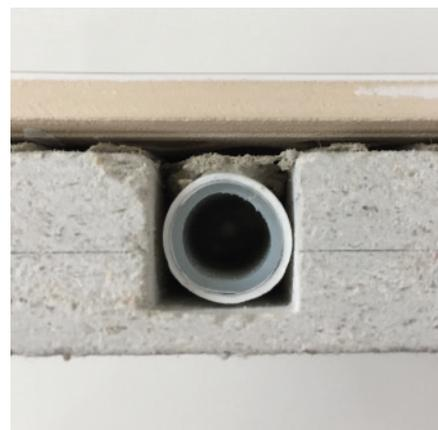
**Photos à droite:** les tuyaux multicouches de haute qualité et à longue durée de vie sont soigneusement posés dans les rainures fraisées avec précision. Une couche supplémentaire n'est pas nécessaire.
