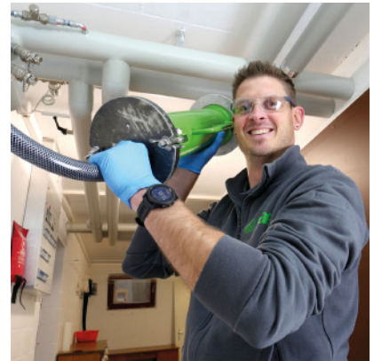
Machines pour l'assainissement avec le HAT-System | Collaborateur en train de sabler et qui, ensuite, procédera à l'injection des serpents.
